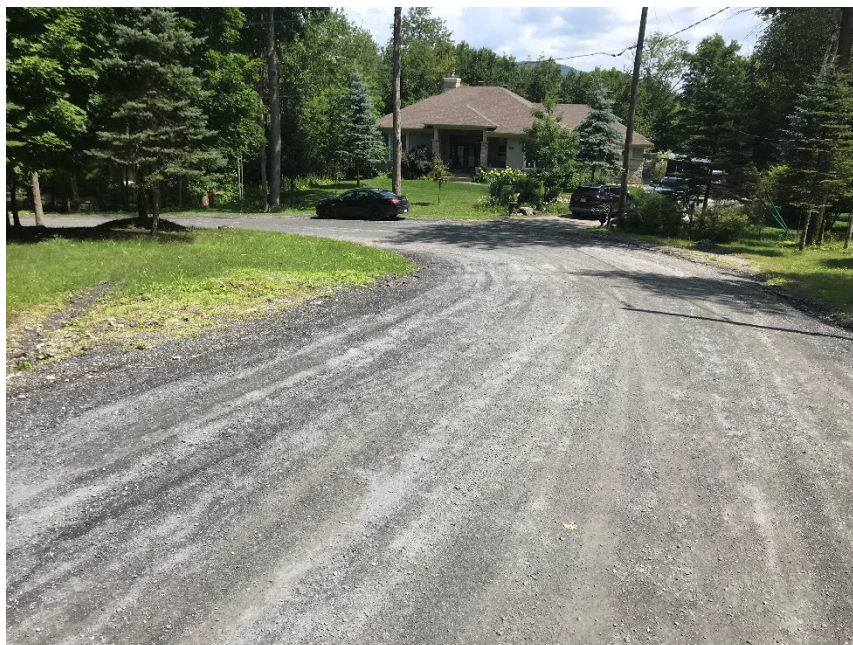
Figure 4 : Rue des Hauts-du-Lac (segment n° 2 - chaînages 1+150 à 1+345)
