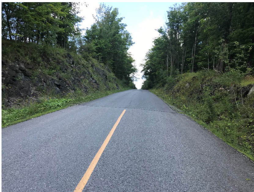
Figure 3 : Rue des Hauts-du-Lac (segment n° 1 - chaînages 1+000 à 1+150)
