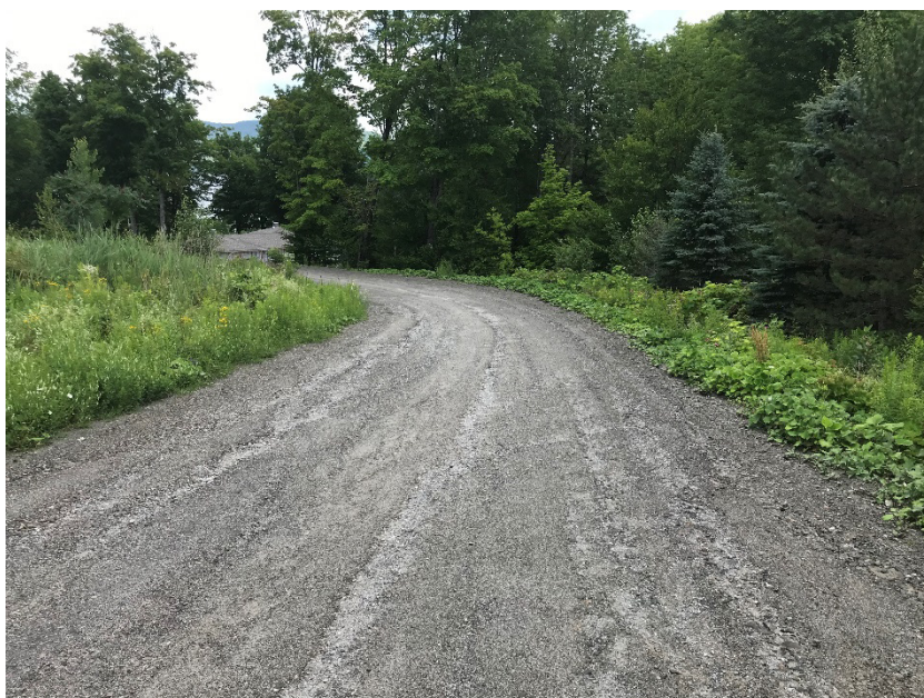
Figure 9 : Rue du Haut-de-la-Falaise (segment n° 7 – de la rue des Hauts-du-Lac au chaînage 3+140)
