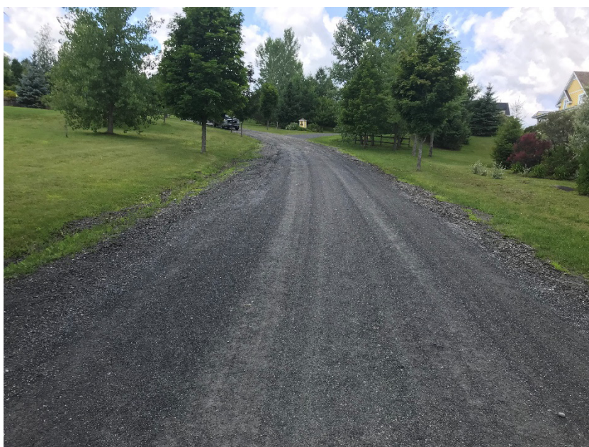
Figure 8 : Rue des Hauts-du-Lac (segment n° 6 – de la rue du Haut-de-la-Falaise à la fin de la rue)
