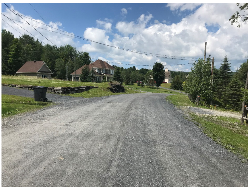
Figure 7 : Rue des Hauts-du-Lac (segment n° 5 - chaînage 1+730 à la rue du Haut-de-la-Falaise)
