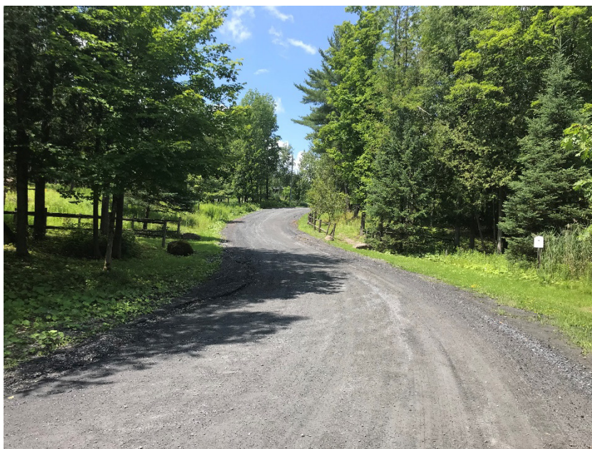
Figure 6 : Rue des Hauts-du-Lac (segment n° 4 - chaînages 1+420 à 1+730)
