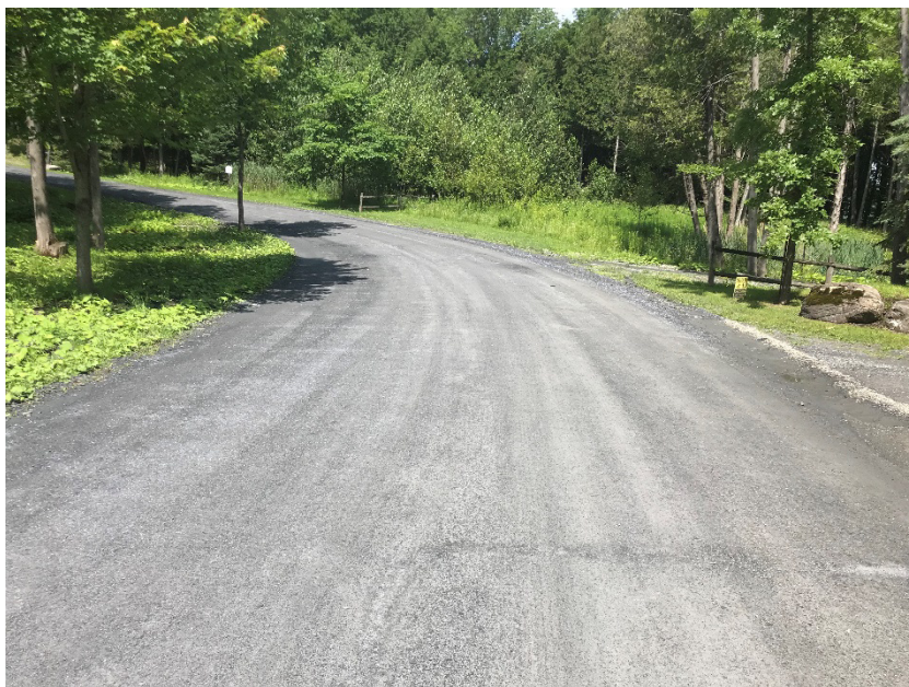
Figure 5 : Rue des Hauts-du-Lac (segment n° 3 - chaînages 1+345 à 1+420)
