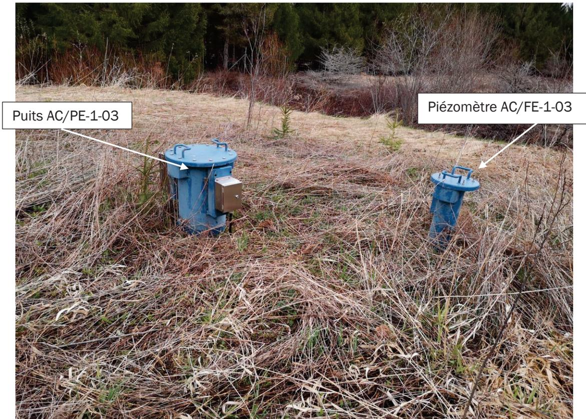
Figure 5 : Vue du puits AC/PE-1-03 (X0008487-4) et son piézomètre AC/FE-1-03
